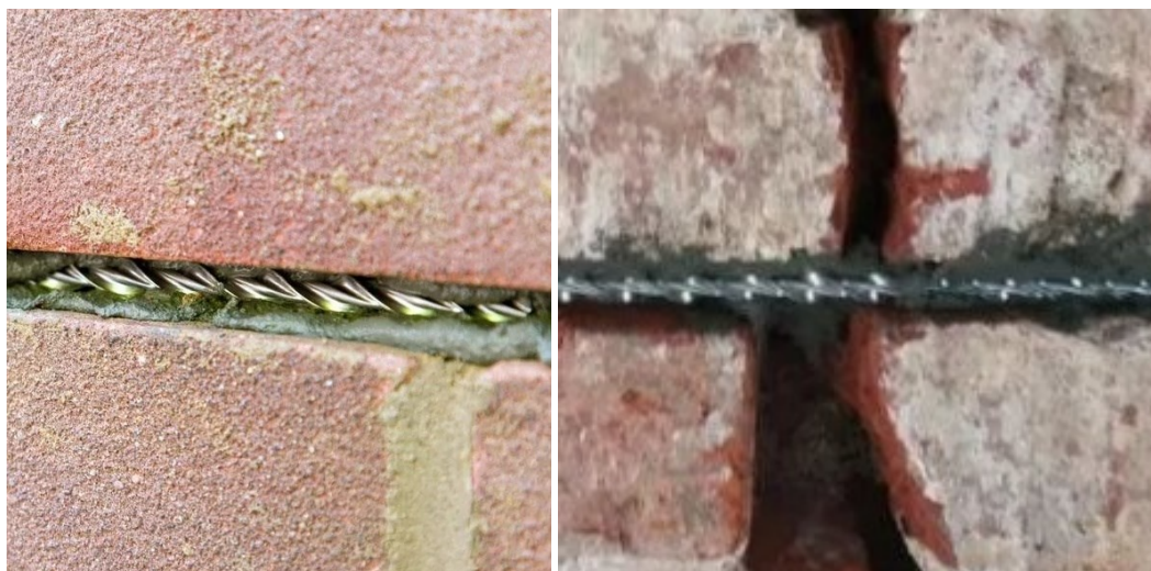
Рис. 3. Усиление каменной кладки спиралевидными стержнями
